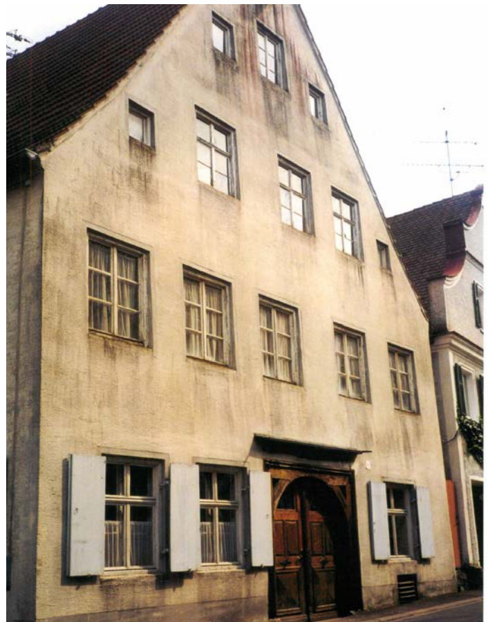
Die Fassade vorher, im Jahr 2004. Bild: Wilhelm Hertle.
